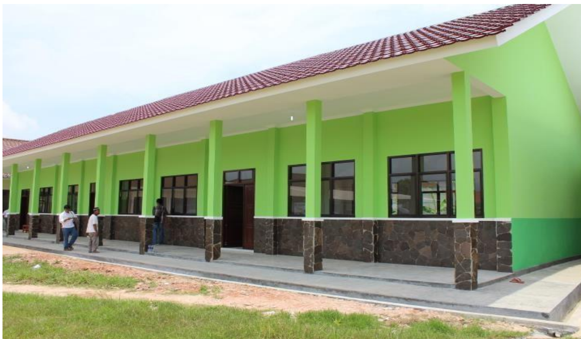
Gambar 2.1 Pembangunan Ruang Kelas Baru (RKB)
