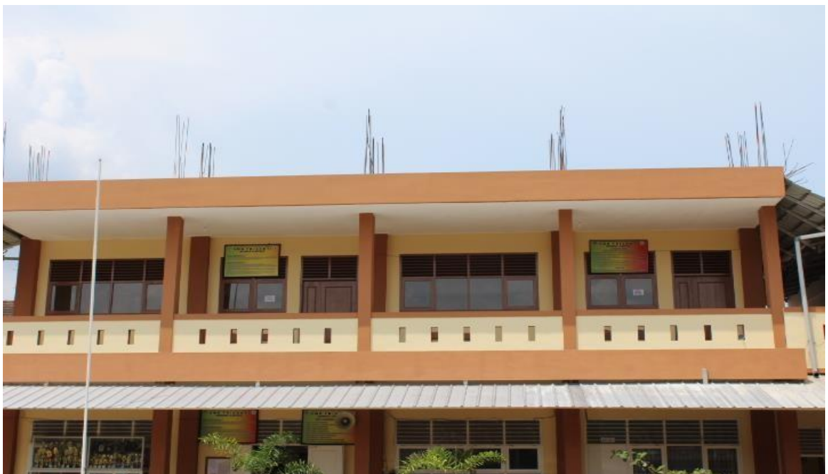
Gambar 2.7 Pembangunan Ruang Kelas Baru (RKB)
