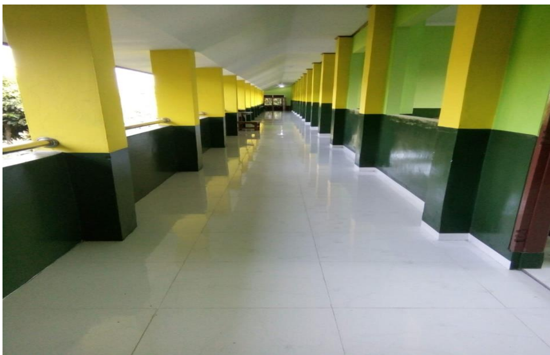
Gambar 2.9 Pembangunan Ruang Kelas Baru
