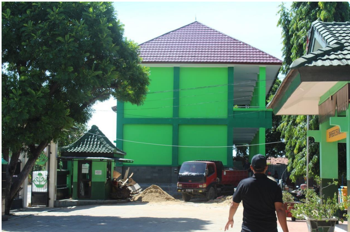
Gambar 2.5 Pembangunan Ruang Kelas Baru (RKB)
