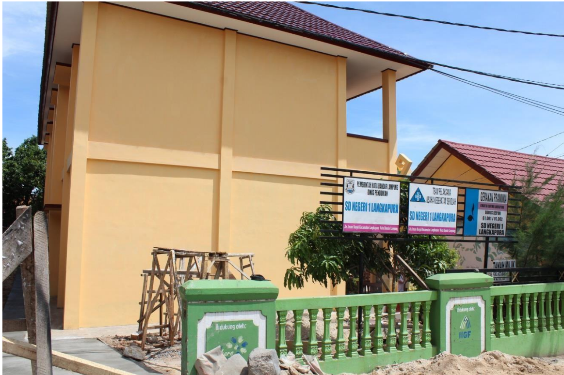
Gambar 2.6 Rehabilitasi Gedung Sekolah
