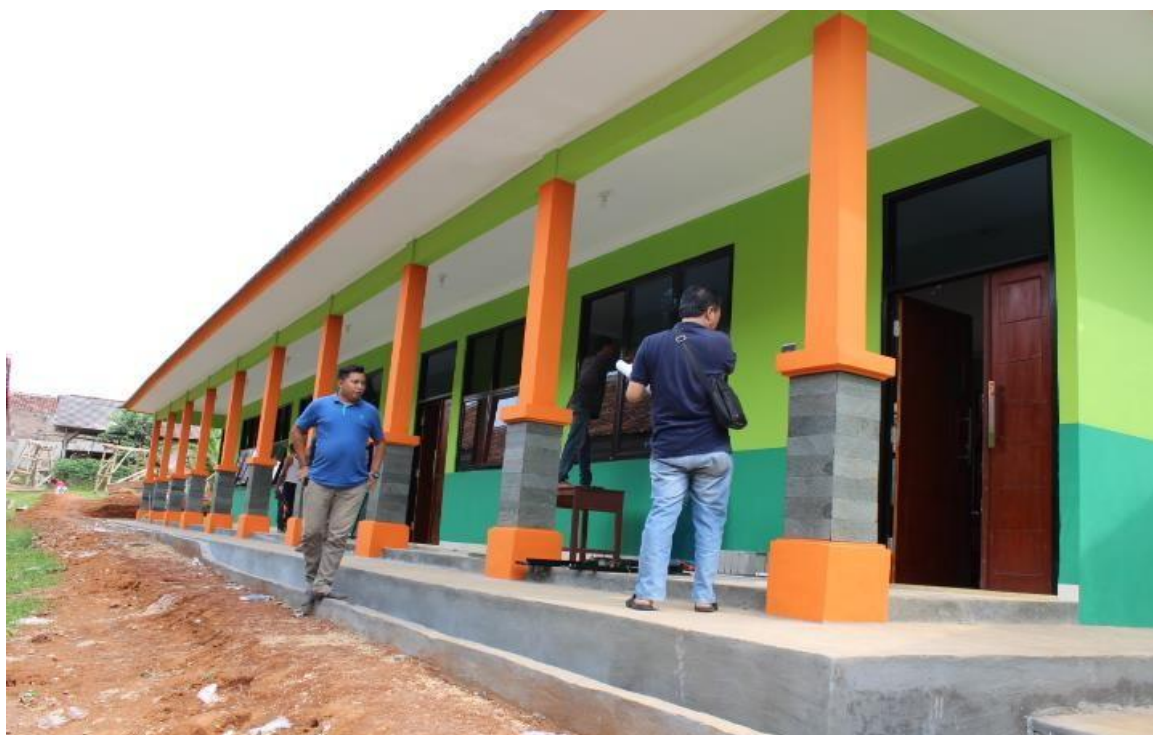
Gambar 2.2 Pembangunan Ruang Kelas Baru (RKB)
